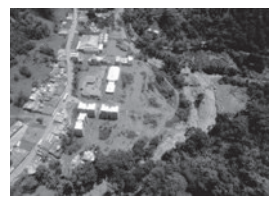
Figura 2-7. Avenida torrencial ocurrida en entre la noche del 17 y la madrugada del 18 de mayo del 2015. Quebrada Liboriana, municipio de Salgar, Antioquia. Foto tomada por Jafed Naranjo.
